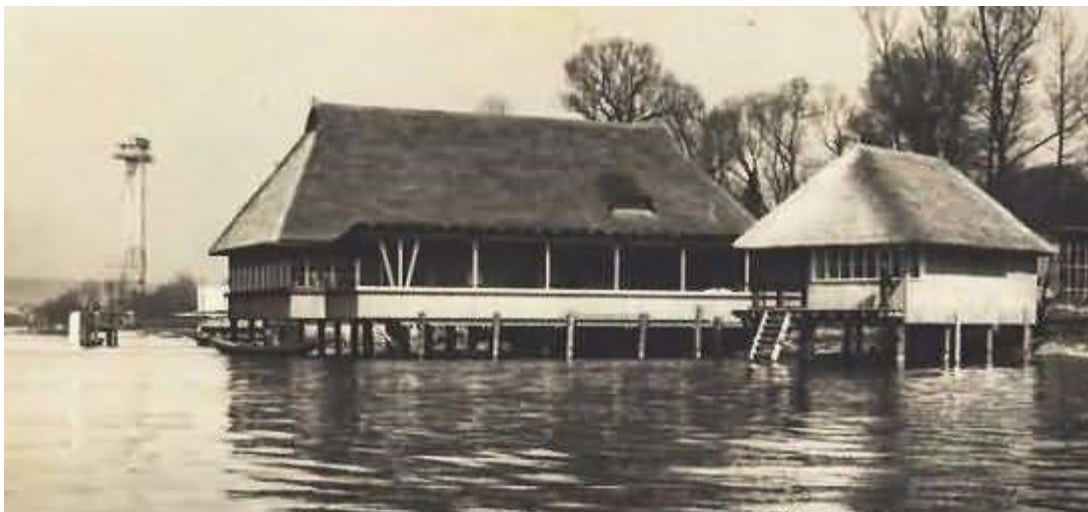
Rest. Fischerstube Zürichhorn (Landi, 1939)
